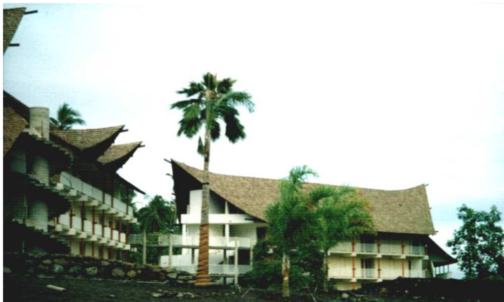
Le Méridien Punaauia en construction
