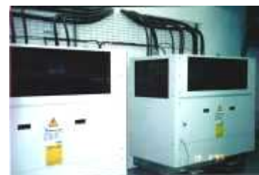
Transfo 2000 Kva Le Méridien Nouméa
